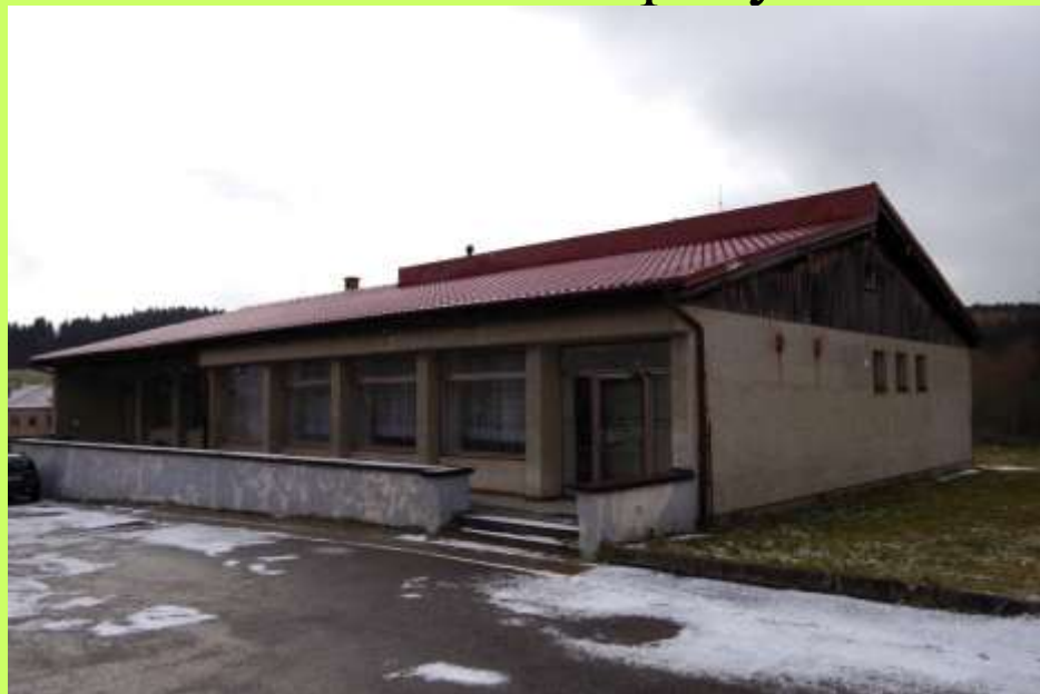
Budova bývalého obchodu a hospody v Polné na Šumavě v listopadu 2017.
